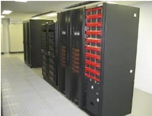
図 7・5 HVDC 実証試験装置の外観
