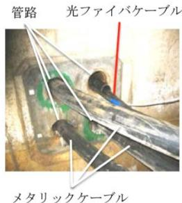
**図 4・41** 地下管路と既設ケーブルの例
