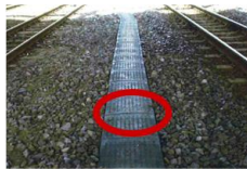
【鉄道通信用トラフ使用例】 (写真提供：越谷金属(株))
